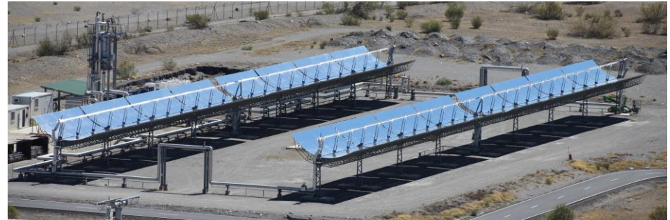
Planta piloto PROMETEO (PTs de gran apertura) (banco ensayo para nuevos fluidos siliconas)
