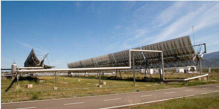
Lazo HTF(aceite térmico) (cualificación de componentes para parabólicos (PT))
