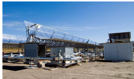
Planta piloto IFL (CO 2 comprimido como fluido térmico)
