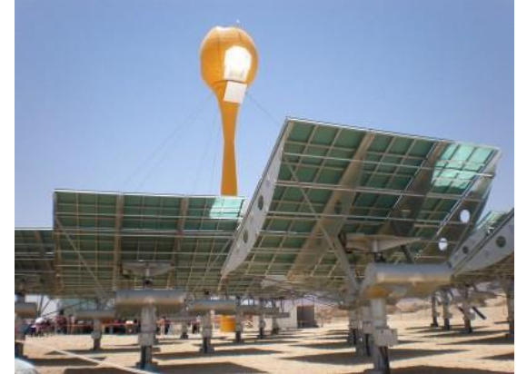
AORA SOLAR (Ensayo de receptores volumétricos presurizados y turbinas de gas solarizadas)
