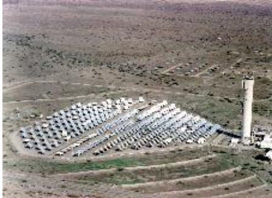
Torre CESA-I (Ensayo de receptores y heliostatos)
